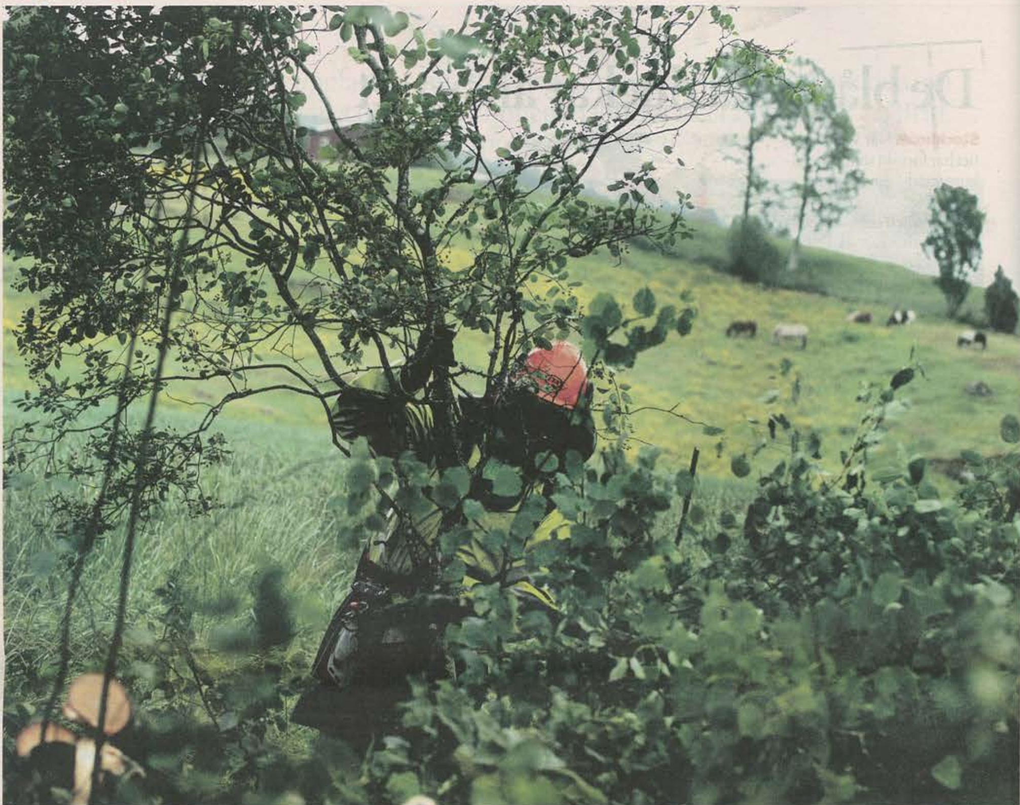
Att röja sly och skog under kraftledningar är svettigt och kräver både kondition och styrka. Skogsröjarna angriper en tätbevuxen kulle som soldater stormar en fästning. Foto: MARIA STÉEN
